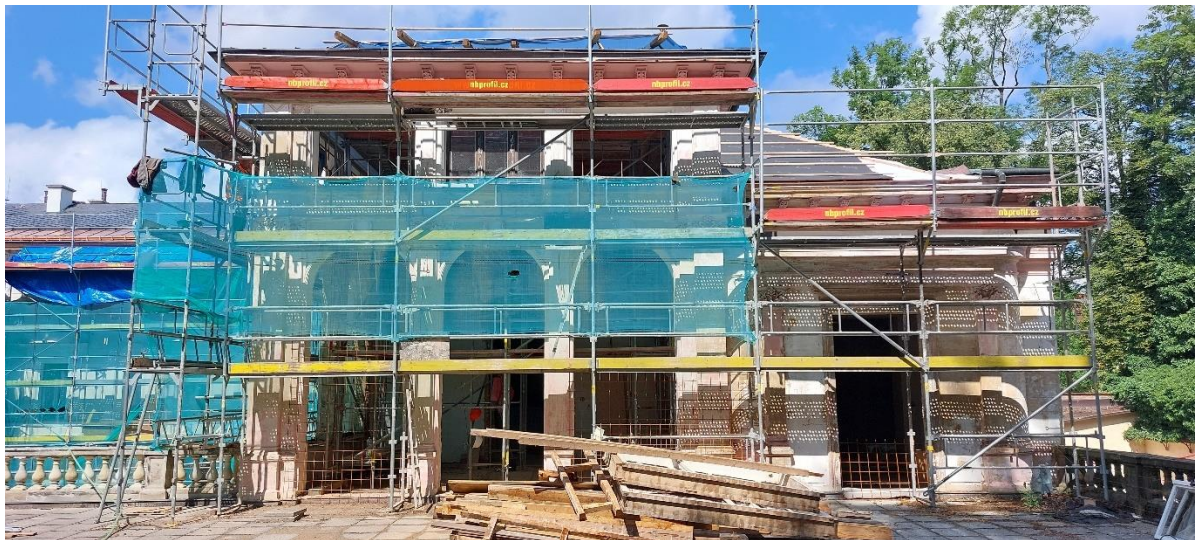
Prostory budoucí kavárny a znovuobnovení francouzských oken
